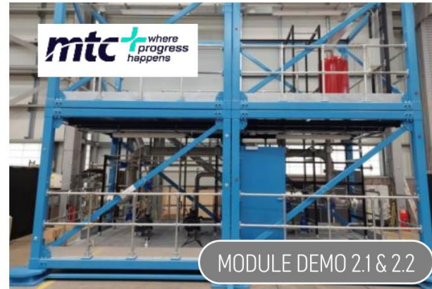
MKoP Dev, Module Install & Construction
